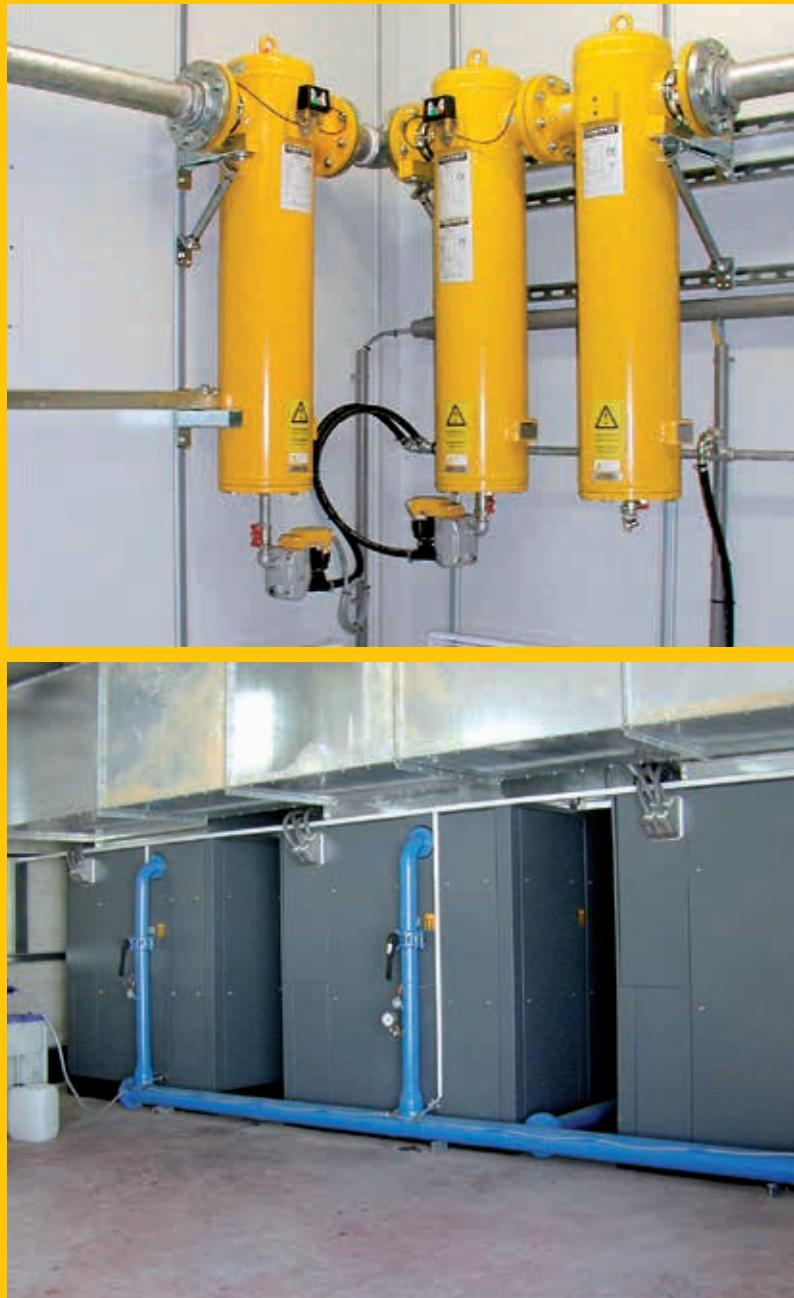
TechnoAlpin utilizza nell'approvvigionamento dell'aria i compressori costruiti secondo i più moderni risultati della tecnica di condizionamento dell'aria. Solo grazie al raffreddamento dell'aria ad una temperatura ottimale è possibile raggiungere il rendimento migliore nella produzione della neve. Per tutelare al meglio l'ambiente, i compressori per aria centralizzata vengono azionati con olio biodegradabile. Un gioco con i componenti che il nostro Engineering padroneggia in modo virtuoso.
